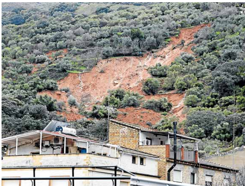
Grave deslizamiento de una ladera que ha obligado a desalojar a vecinos en Benaoján. SALVADOR SALAS
