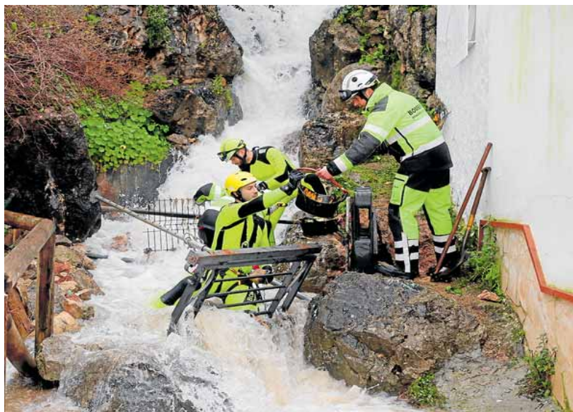
Bomberos trabajan en la localidad gaditana de Ubrique, una de las más afectadas. SUR
